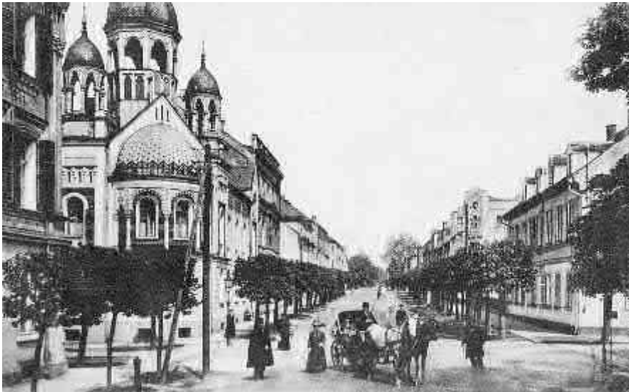
links: die ehemalige Synagoge
