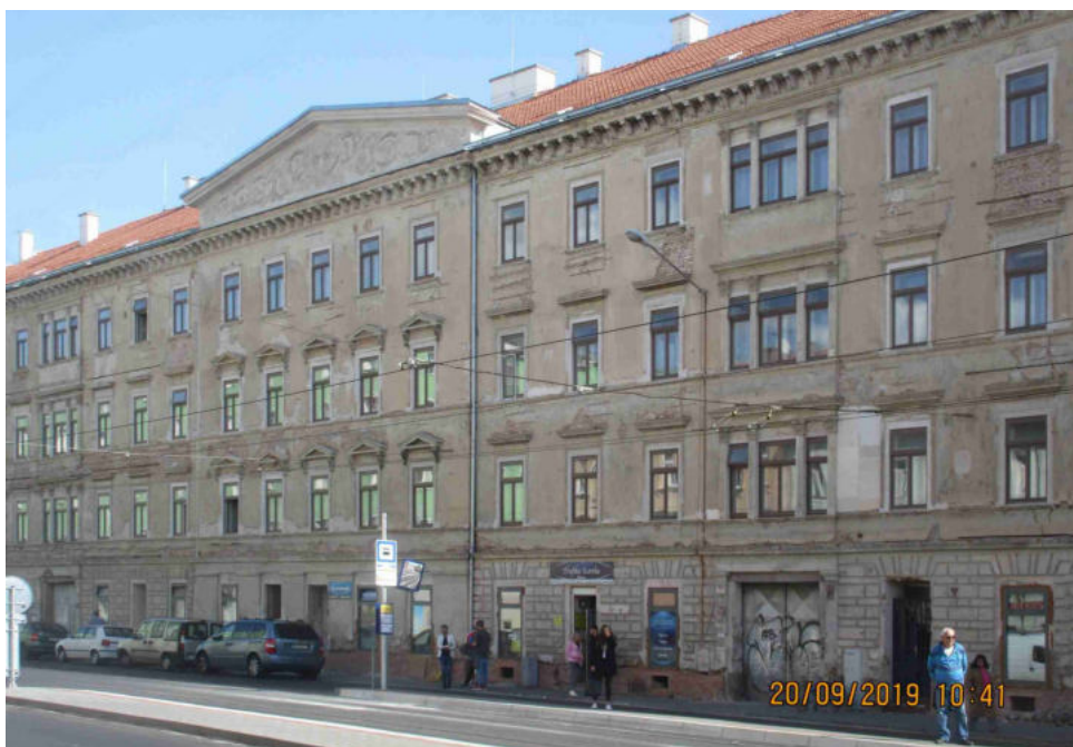
Eines der noch erhaltenen ehemaligen Fabrikgebäude der Weberei-Firma Soxhlet im jetzigen Zustand
