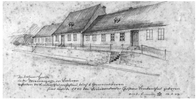
Der Zug führt vorbei am Platz des ehemaligen Geburtshauses Wienergasse 20 des österreichisch-amerikanischen Brückenbauers Dr.-Ing. e. h. Gustav Lindenthal
